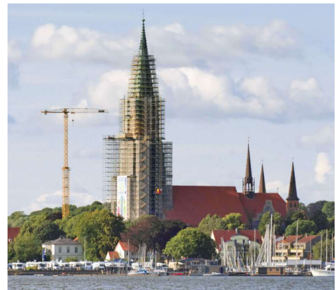
Der Dom von Süden während der Sanierung
