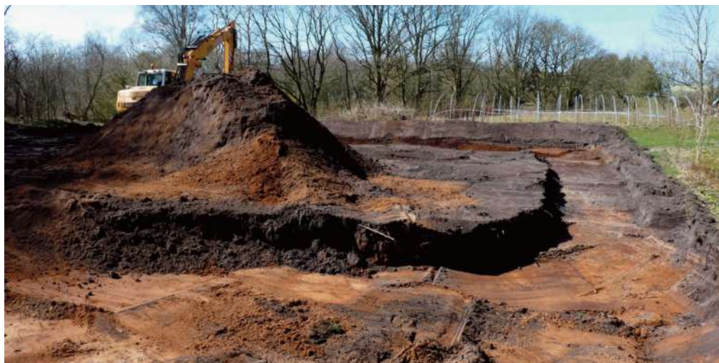
Abb. 2: Nicht wiederzuerkennen: Nach 8 Stunden ist auf 900 m 2 die Humusschicht entfernt
