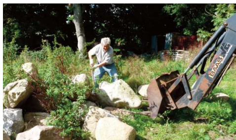
Abb. 5: Findlinge aus Osterbyholz werden für eine Trockenmauer aufgeschichtet
