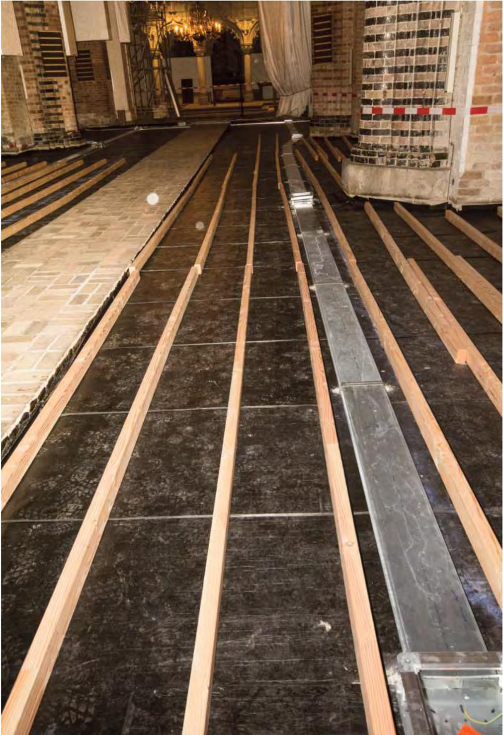
*Abb. 40: Im Sommer 2021 wurde im Hauptschiff des Doms der Fußboden erneuert. Hier ist die Unterkonstruktion kurz vor dem Verlegen der Bodenbretter zu erkennen.*
