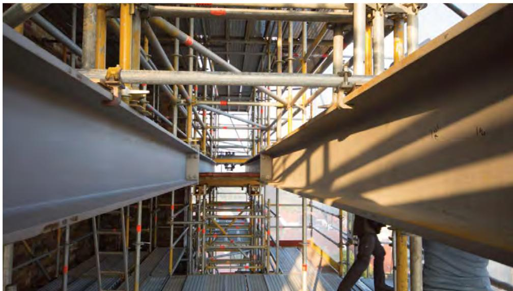
Abb. 20: Alle zwei Meter wurde im Außengerüst eine neue Gerüstlage eingezogen. So konnten alle Außenbereiche des Turms durch die Handwerker für ihre jeweiligen Tätigkeiten gut erreicht werden. Vorsichtig mussten allerdings größer gewachsene Menschen sein. Durch die leicht beengte Raumsituation war der Kopf stark gefährdet. Das Bild gibt einen Eindruck davon wieder. Helme waren Pflicht!!
