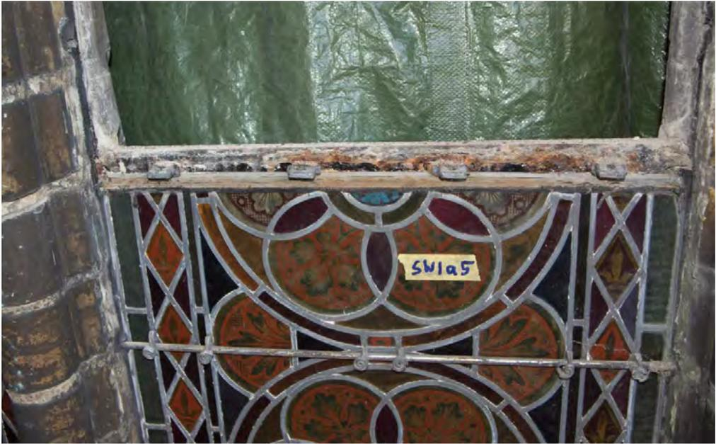
*Abb. 27: Damit das große Puzzle nach dem Ausbau und der Sanierung in der Werkstatt auch wieder sinnvoll zusammengesetzt werden konnte, wurden alle Glaselemente in einem nachvollziehbaren System durchnummeriert. Ein Fehler beim Wiedereinbau ist bisher nicht entdeckt worden. Sollte jetzt – drei Jahre nach Bauende – noch jemand einen Fehler finden, dann bitte nicht (!) melden.*
