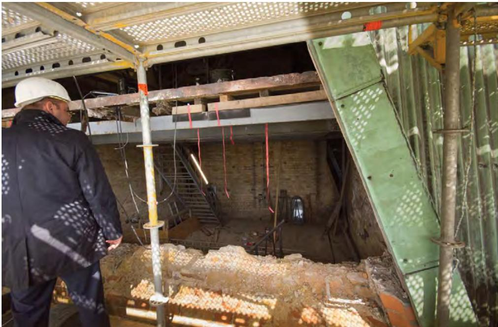
*Abb. 2: Abriss des Mauerwerks bei großflächigem Schadensbild, hier in Höhe des Ansatzes des Turmhelms vom Bagerüst aus mit Blick in den Innenraum des Turms. Die Stärke des Mauerwerks ist gut zu erkennen und selbst in dieser Höhe noch beträchtlich. Zum Vergleich: Am Fuß des Turmes beträgt die Mauerstärke zum Teil deutlich über zwei Meter.*
