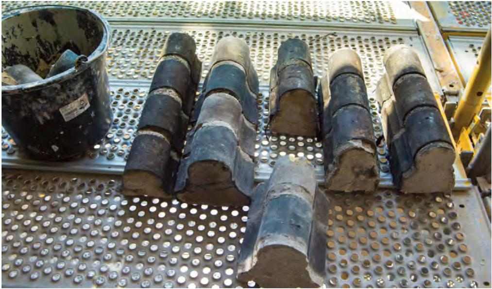
Abb. 29: Im Anschluss an das Bild Nr. 28 sieht man hier ausgebauten Maßwerksteine, die – soweit möglich – wieder verwendet wurden oder aber durch neue Steine ersetzt wurden. Die in diesem Kontext neu produzierten Ersatzsteine waren jeweils gesonderte von Hand gefertigte Exemplare, die nur in kleiner Stückzahl in Auftrag gegeben wurden. Auch sie kamen aus dem sächsischen Zieglerwerk, in dem auch das für diese Arbeiten notwendige Knowhow gegeben war.
