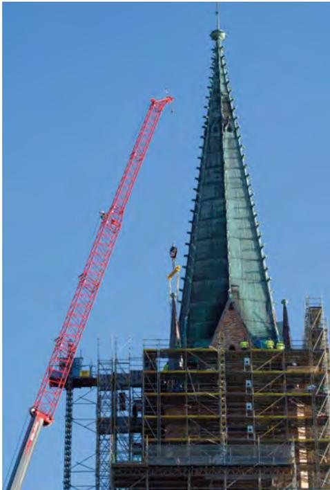
*Abb. 13: Während das Hauptgerüst am Ende der Baumaßnahme langsam zurückgebaut wird, werden die überarbeiteten Helme der Filialtürme wieder aufgesetzt. Sowohl beim Helm des Hauptturmes als auch bei den Filialtürmen wurde davon abgesehen, diese komplett mit Kupfer neu zu verkleiden. Vielmehr wurde in sehr umfangreicher Detailarbeit die alten Kupferelemente bewahrt und wieder in Stand gesetzt.*
