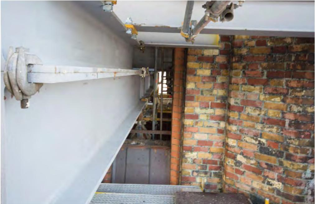
Abb. 5: Auch in diesem Bild ist deutlich das alte Mauerwerk zu erkennen. Gleichzeitig sieht man die Stahlträger, die durch die Schallluken des Turms geschoben wurden und dort der Fixierung der höheren Gerüstlagen dienen. Die räumliche Nähe von Stahlträgern und Mauerwerk verdeutlicht die komplexe statische Herausforderung, die die großflächige Sanierung des Domturms darstellte. (vgl. dazu auch oben Kapitel 2)
