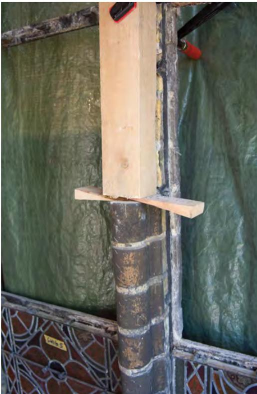
*Abb. 28: Hier wurden beschädigte Maßwerksteine ausgebaut und übergangsweise durch eine Holzkonstruktion ersetzt. Der Ein- und Ausbau einzelner Steine des sehr filigranen Mauerwerks wurde durch Steinmetze vorgenommen, deren Arbeit schon sehr an ein Kunsthandwerk erinnert.*
