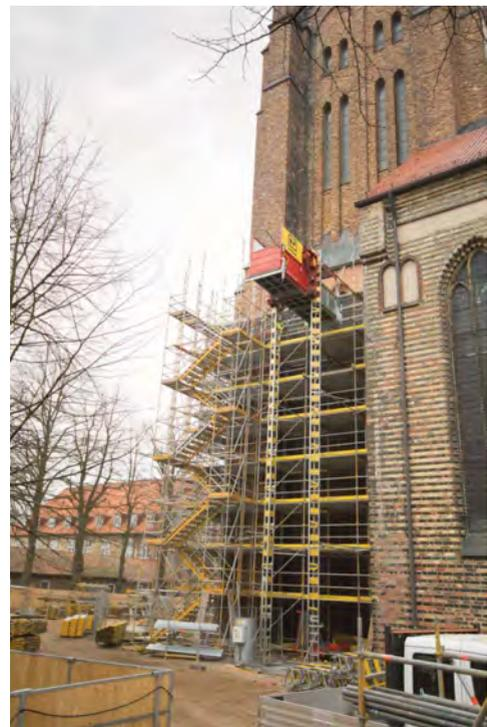
Abb. 18: Nachdem durch einen späten Wintereinbruch die Arbeiten an den Gerüstfundamenten einige Wochen ruhen mussten, wurden im April 2018 die ersten Gerüstlagen wie hier an der Südseite des Domturmes aufgebaut.
