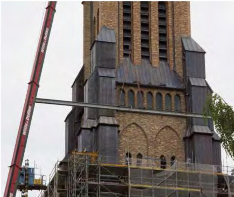
Abb. 12: Auch dieses Bild gibt aus der Halbdistanz, während der Arbeiten zum Abbau des Gerüstes entstanden, einen guten Eindruck vom Domturm nach der Fertigstellung und vom Einbau der Kupferelemente. Ebenfalls sind an den Kupferelementen zwischen den Schallluken und den Fenstern der Aussichtsplattform die neuen Beleuchtungselemente zu erkennen, die dem Turm im Dunkeln eine besondere Anmutung verleihen.
