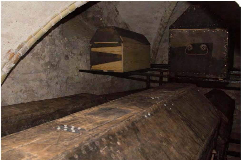
Abb. 34: Diese Aufnahme eines Ausschnitts der unteren Fürstengruft an der Nord-Ost-Ecke des Chores zeigt das Ergebnis der Sicherungsmaßnahmen in der Gruft, das vor allem aus dem Einbau der Lagerungsgerüste besteht. Zudem wurden die Särge und Sarkophage wo nötig so in Stand gesetzt, dass ein würdiges Gesamtbild erreicht werden konnte.
