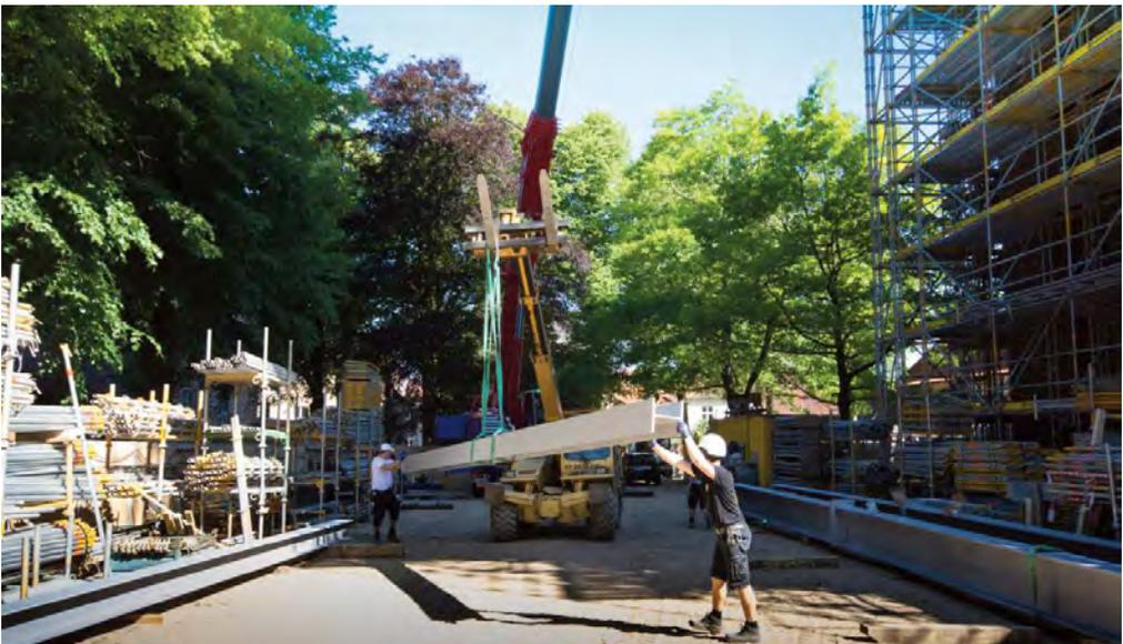
Abb. 45: Gerüstbauer im Juni 2018 bei der Lagerung der Stahlträger
