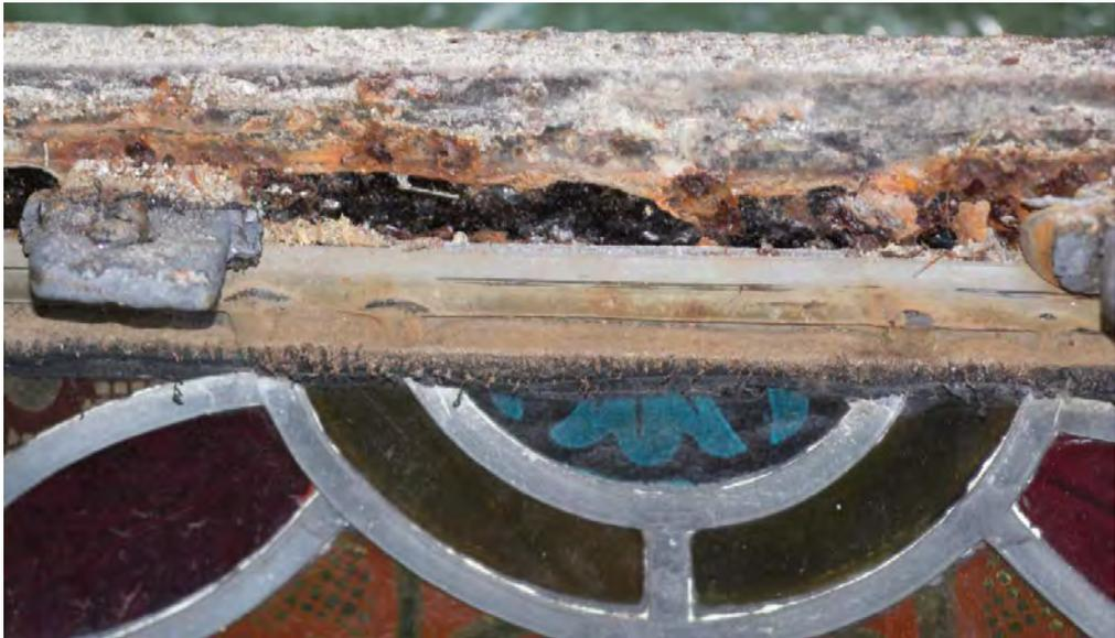
*Abb. 26: In dieser Detailansicht ist der Korrosionsschaden am Sturmeisen klar auszumachen. Man sieht hier zudem sehr gut die Konstruktion der Glasfenster. Die quadratischen Glaselemente hängen an den querlaufenden Eisen und bilden wie ein Mosaik die Gesamtheit des Fensters.*
