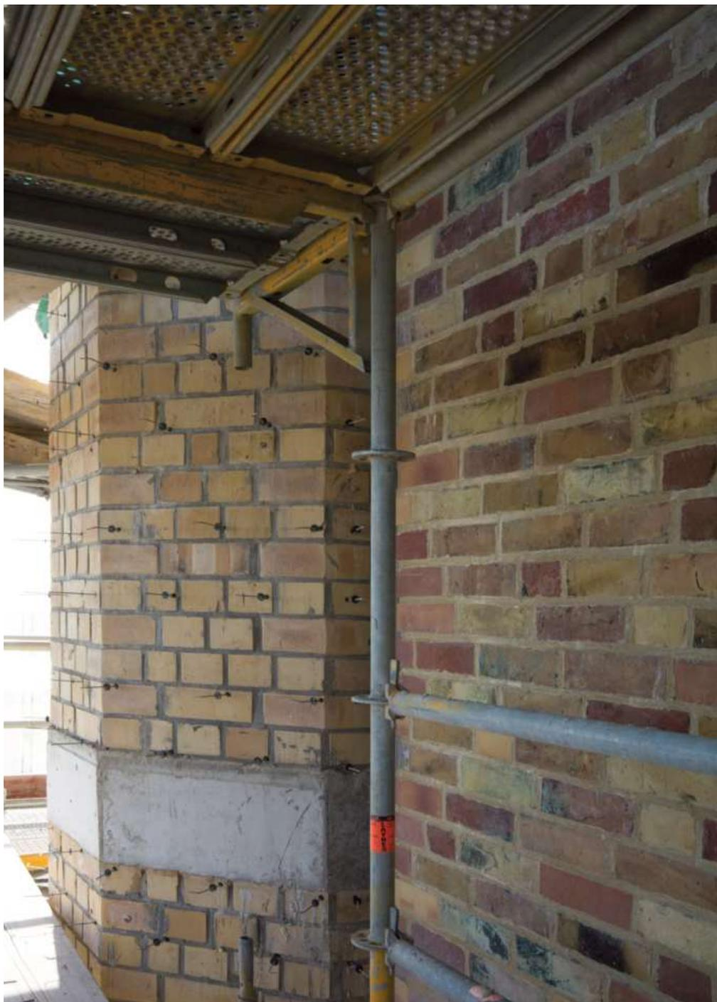
*Abb. 7: Ausschnitt eines sanierten Mauerabschnitts. Im Vordergrund ist deutlich das fertige, mit Backsteinen verblendete Mauerwerk eines großflächigen Stückes zu erkennen, im Hintergrund das neue Kernmauerwerk eines der beiden westlichen Filialtürme, die ebenfalls komplett erneuert worden sind. Diese Filialtürme wurden im Anschluss mit Kupferelementen verblendet. Die alte Backsteinverblendung wurde hier durch den „modernen“ Baustoff Kupfer ersetzt.*
