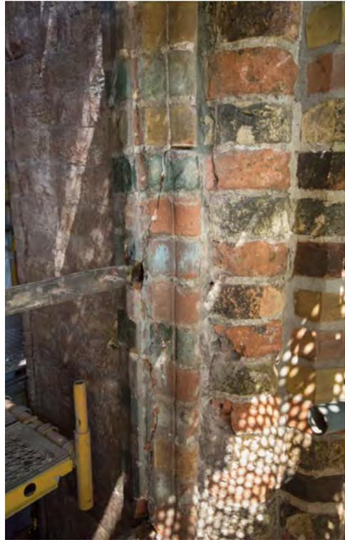
*Abb. 25: Dieses Bild zeigt sehr eindrücklich sowohl die Schäden im Maßwerk – hier die Risse im gemauerten Fensterrahmen – als auch die Schäden an dem Punkt, an dem das Sturmeisen in das Mauerwerk einläuft.*
