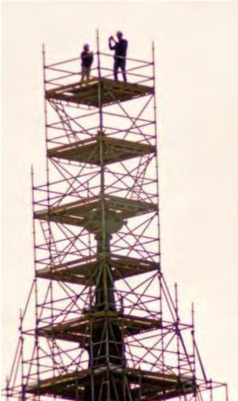
Abb. 17: Nur für einige Monate – nämlich im Sommer 2020 – war der Domturm komplett über die Spitze in Höhe von 114 Metern eingerüstet. Alle Arbeiten in dieser Höhe am Turmhelm mussten in jenen Wochen durchgeführt werden. So gab es auch nur in diesen Wochen die Möglichkeit, oberhalb der Turmspitze das Baugerüst zu erklimmen. Wer die nötige Schwindelfreiheit besaß, ließ sich das nicht entgehen.
