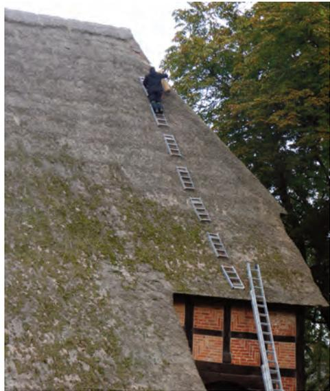
Abb. 4: Reparaturarbeiten am Dach der Weizenscheune
