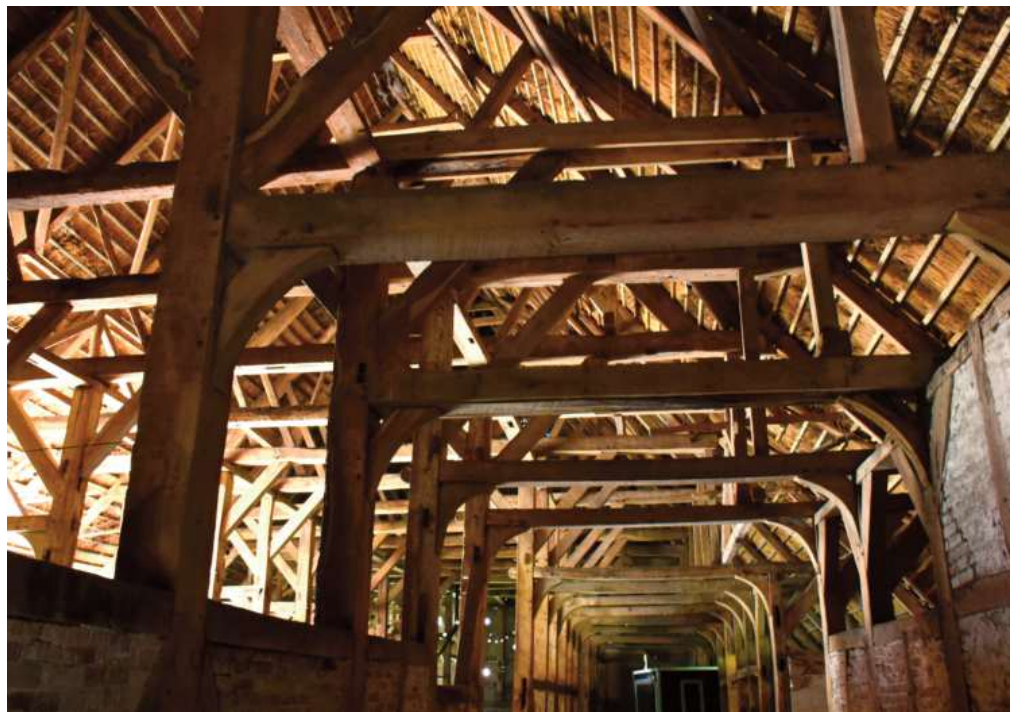
Abb. 2: Innenraum der Scheune
