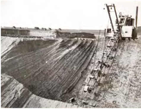
Abb. 11: Baggereinsatz in der Mergelgrube Ladelund in Nordfriesland 1913. Hans Feddersen, Kirchspielarchiv Ladelund, 2013
