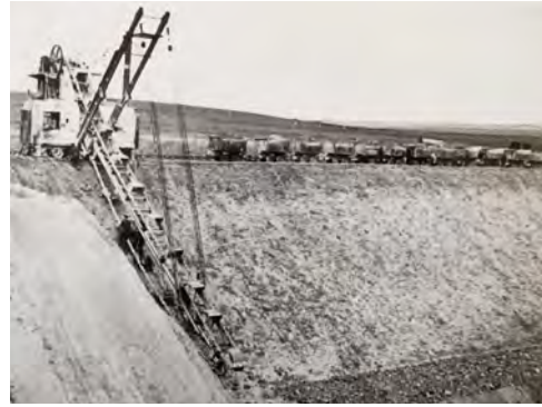
Abb. 12: Mergelbahn zum Abtransport mit Loren und über Schienen. Hans Feddersen, Kirchspielarchiv Ladelund, 2013
